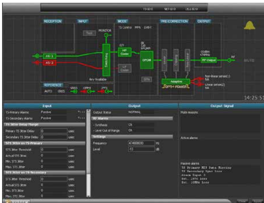
Interface Web de contrôle
